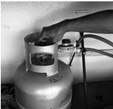
ガスボンベ、調整器、接続ホース、ガス器具はすべて定期的に点検が義務づけられています。
